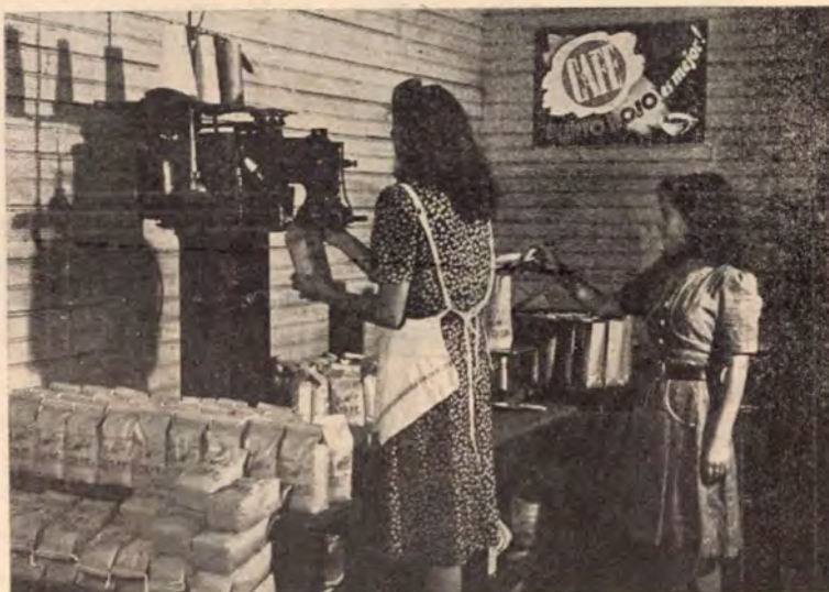
Departamento de empaque del producto, donde se pesa, se cose automáticamente el delicioso café PUNTO ROJO
