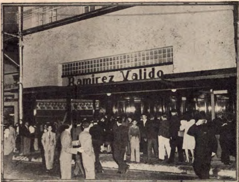
Vista parcial del edificio RAMIREZ VALIDO, el día de su inauguración
