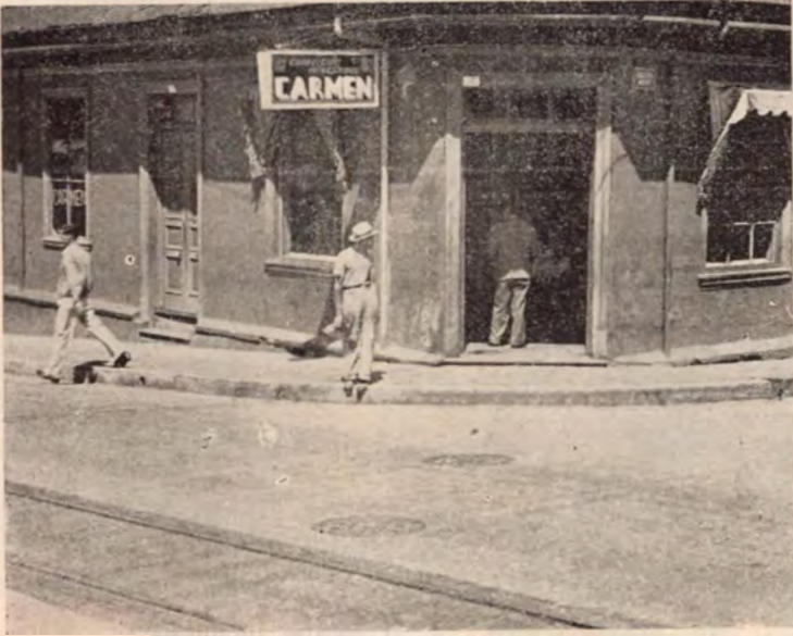
Vista del edificio de la CASA CARMEN
